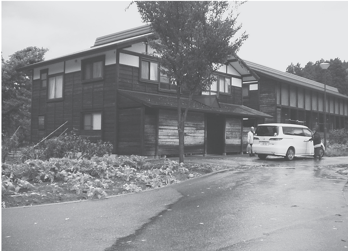
竹沢集落の復興公営住宅。手前が一戸建て、奥が長屋タイプ。
