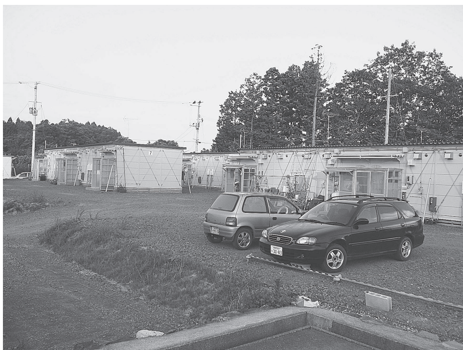
新地町作田応急仮設住宅
