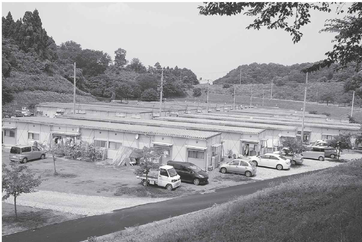
いわき市高久第8仮設住宅。窪地に建てられていた。鋼版ぶきの屋根は強烈な日差しに晒されている。
