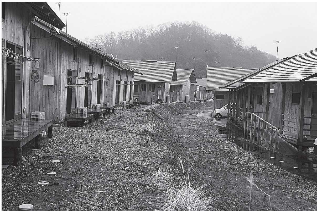
いわき市高久第十仮設住宅団地。地盤の整備はできていなかったが、建物はしっかりした造りだった。
