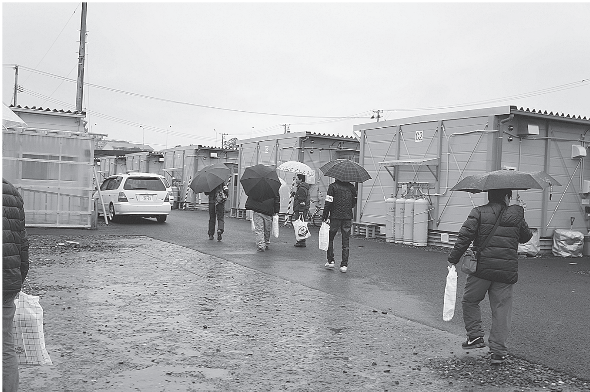
いわき市泉仮設住宅団地。近くに常磐線泉駅がある。造りは今までと違う。
