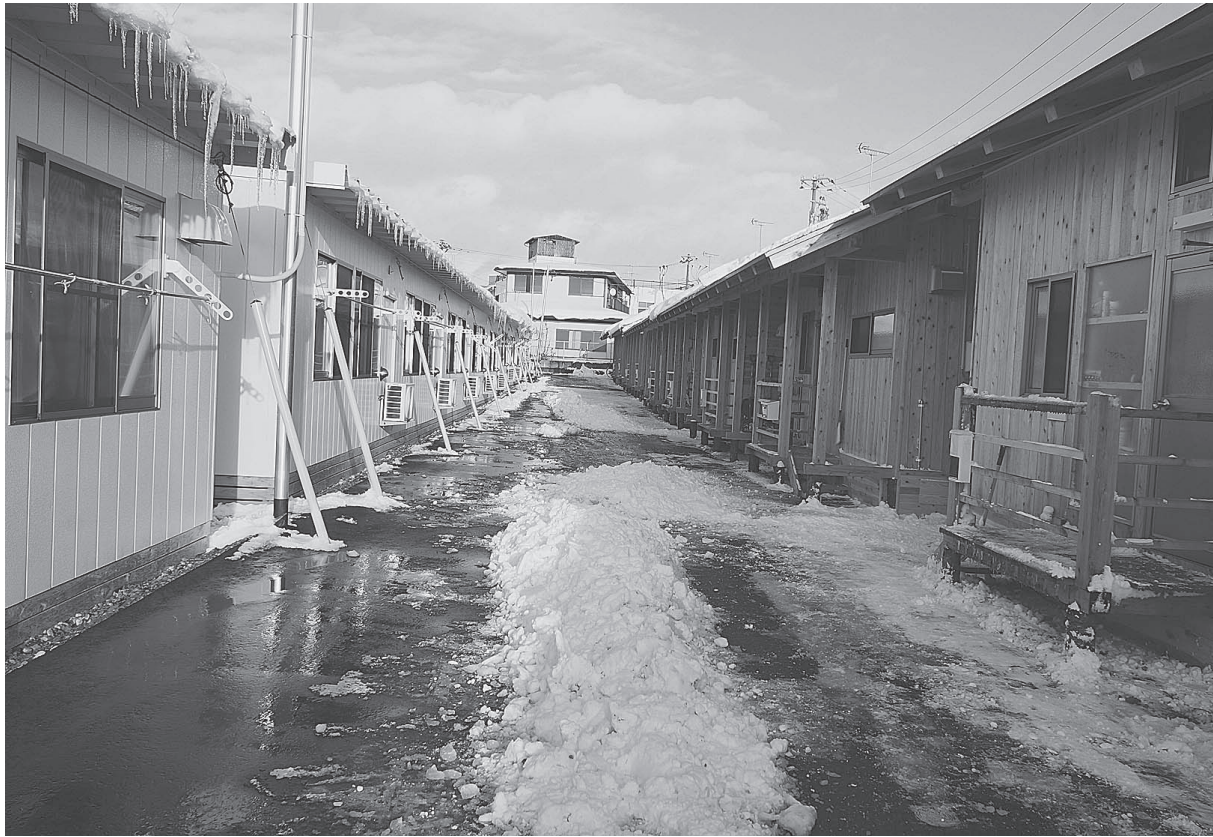
会津若松市城北小学校北団地（54戸） 左棟は屋根がフラット、右棟は傾斜屋根だ。同じ団地のなかで屋根構造が違う。不思議に思われた。
