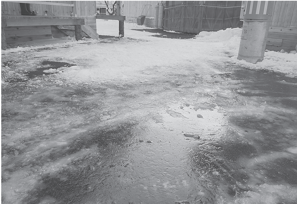
通路には溶けた雪が凍結している。とても危険で歩くことができない。
