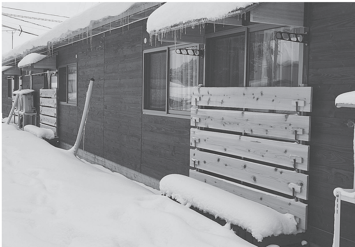
雪の圧力で窓が破壊されるのを防ぐため「雪囲い」が設置されていた。
