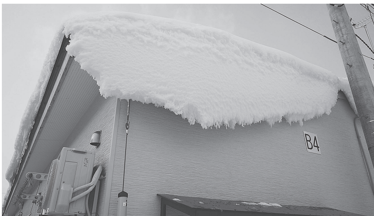
屋根から雪の固まりが垂れ下がっている。今にも落下しそうだ。
