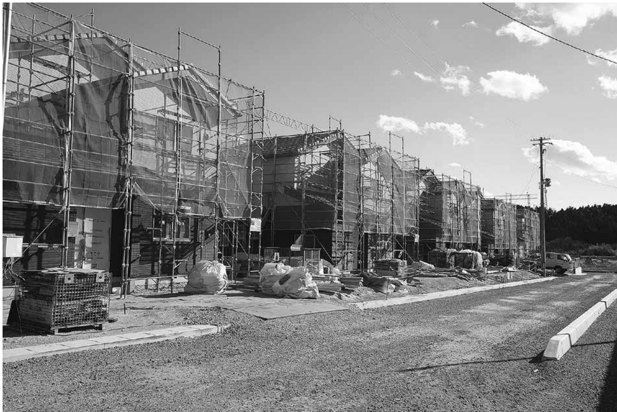
災害復興住宅（戸建て）、足場が外されるのを待つばかり。
