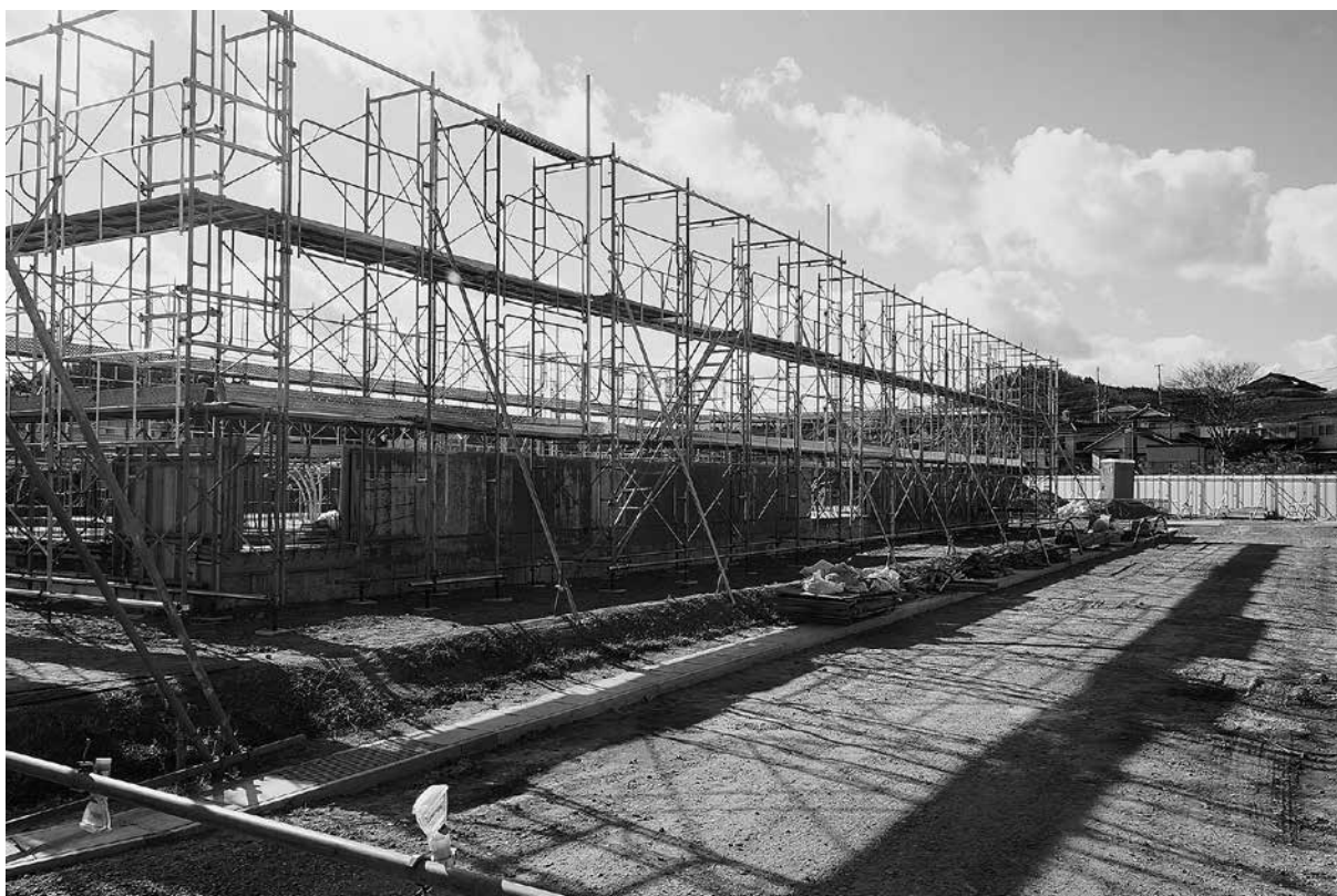
災害復興住宅（共同住宅）、基礎工事が進められている。
